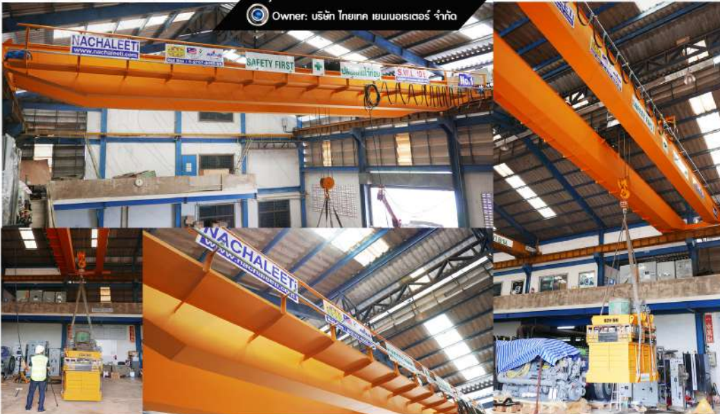
Project: งานติดตั้ง Overhead Crane พักถ้ำหนัก 10 ตัน
