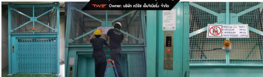
Project: งานติดตั้งลิฟต์บรรทุก 500kg.
