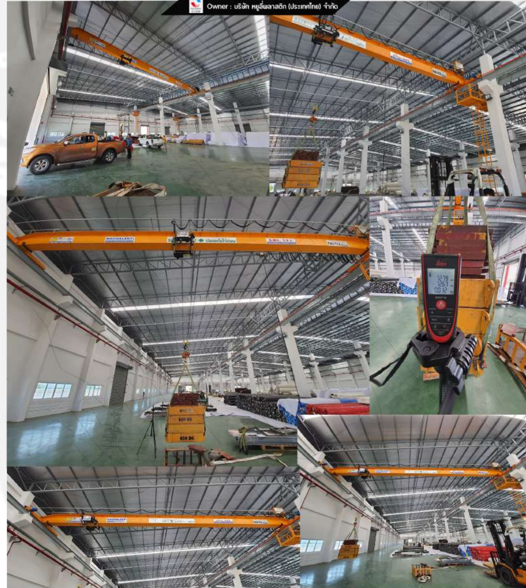
Project : งานติดตั้ง Overhead Crane พิกัดขนาด 3.2 ตัน
