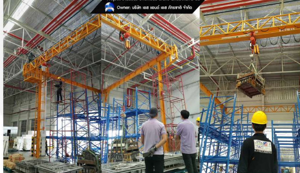
Project: งานติดตั้ง Overhead Crane พักถ้ำหนัก 2 ตัน
