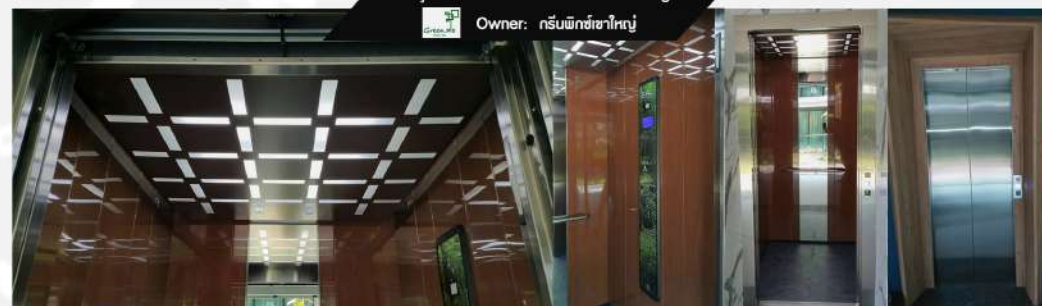
Project: งานติดตั้งลิฟต์โดยสาร P8-630kg.
