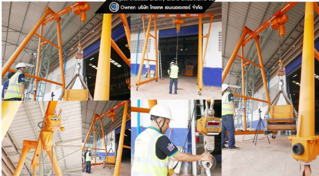
Project: งานติดตั้ง Overhead Crane พักถ้ำหนัก 10 ตัน
