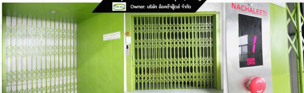
Project: งานติดตั้งลิฟต์บรรทุก 1,500kg.
