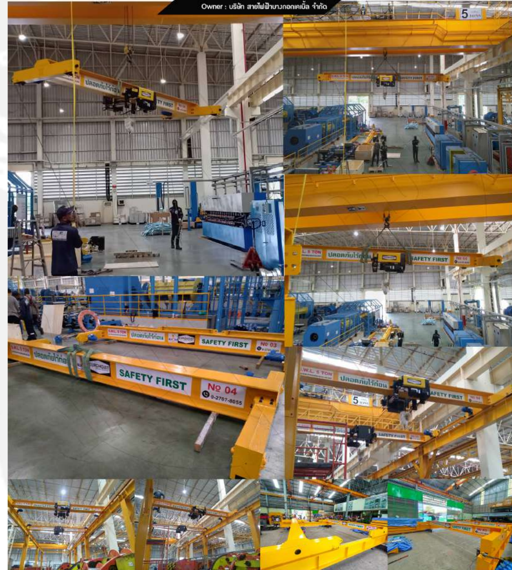
Project : งานติดตั้ง Overhead Crane พื้ที่ขนาด 5 คูณ Owner : บริษัท สายไฟฟ้าบางกอกเคเบิล จำกัด
