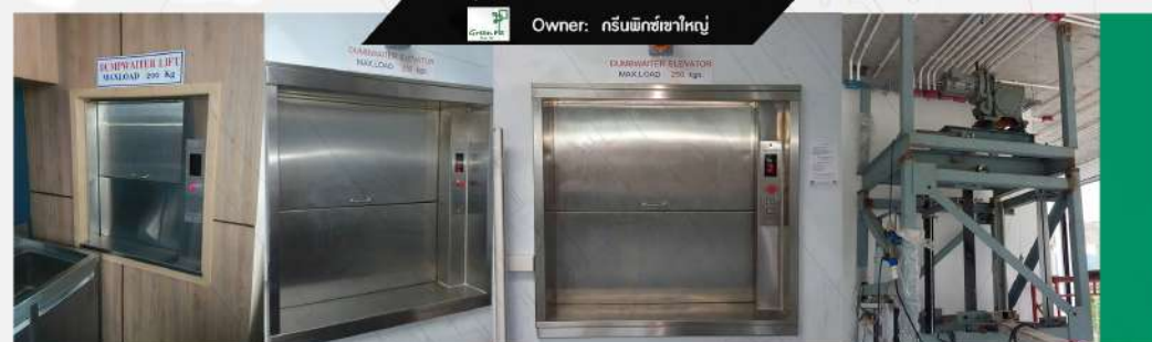
Project: งานติดตั้งลิฟต์ขนส่งอาหาร 250kg.
