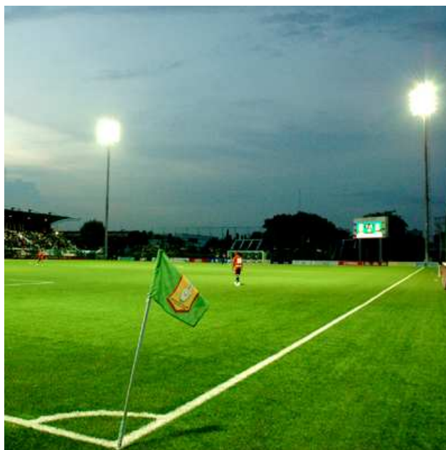
รูปที่ 2.6.4-8 ไฟฟ้าแสงสว่าง แบบเมทัลฮาไลด์
