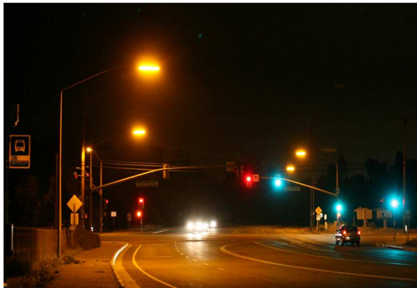
รูปที่ 2.6.4-4 ไฟฟ้าแสงสว่างถนน แบบโซเดียมความดันต่ำ
