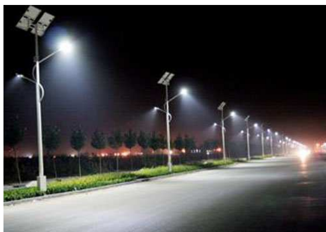
รูปที่ 2.6.4-10 ไฟฟ้าแสงสว่าง แบบ LED
