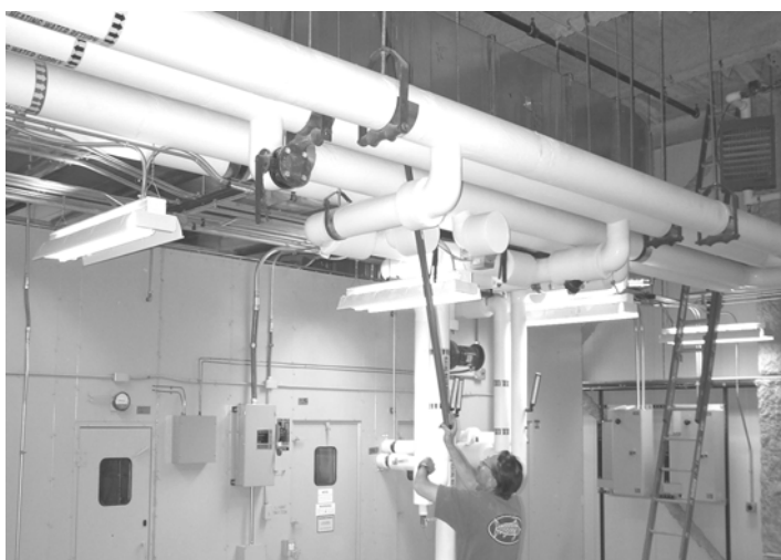
ภาพที่ ง 8 ภาพแสดงการใช้งานอุปกรณ์ช่วยทดสอบ หรือถอด ประกอบอุปกรณ์ตรวจจับในที่สูงโดยไม่ต้องใช้บันได
