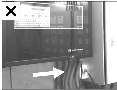
ภาพที่ 4.7 ภาพแสดงการจ่ายกำลังไฟฟ้าให้กับแผงควบคุมผ่านเต้ารับไฟฟ้า เป็นวิธีที่ไม่ถูกต้อง
