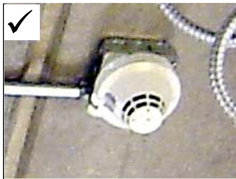
1. ติดอุปกรณ์เข้ากับกล่องพักสายบนเพดานคอนกรีต สายสัญญาณร้อยผ่านท่อที่ต่อกับกล่องพักสาย
